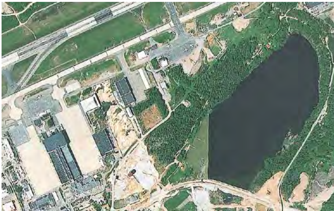
Figur 13. Flygbild över Halmsjön i samband med ljusrampens byggande. Grumling är genom skyddsåtgärder begränsad till den västra delen av sjön.
